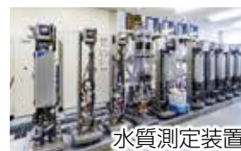
草加部浄水場
