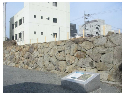
京橋門跡石垣
